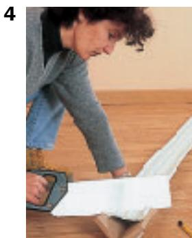
**4. Découper la corniche à 45° en utilisant une boîte à onglets spéciale et une scie à dos à denture fine.**
