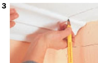
**3. Présenter la corniche dans l'angle et tracer le point de rencontre des corniches dans l'angle des murs.**
