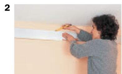
**1. Positionner un morceau de corniche à l'angle mur/plafond pour tracer son emplacement sur le mur ou sur le plafond.**
