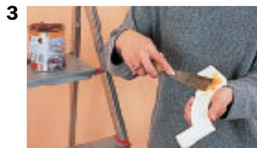
**3. Poser d'abord les angles en les collant à la colle néoprène ou au mastic de fixation.**
